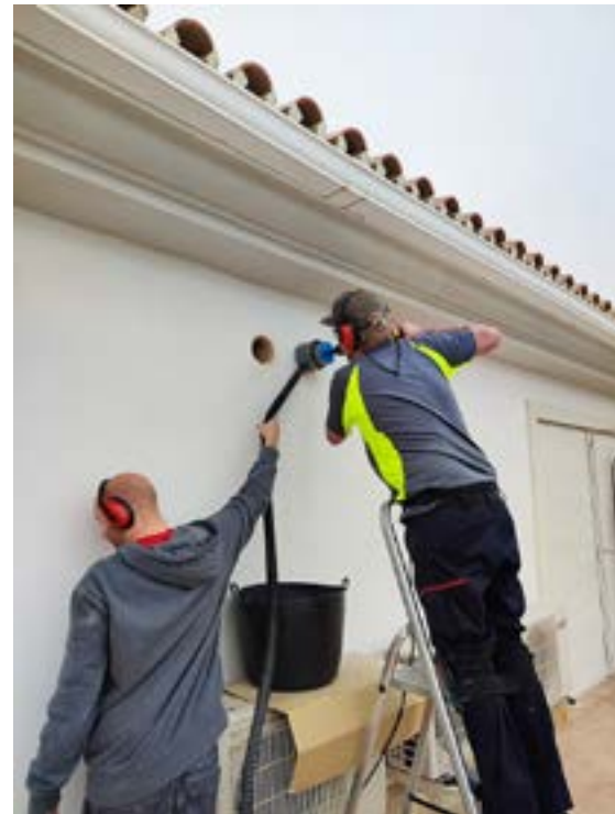
Timanttitoralla venttiilin reikä syntyy paksuinkin seinään.
